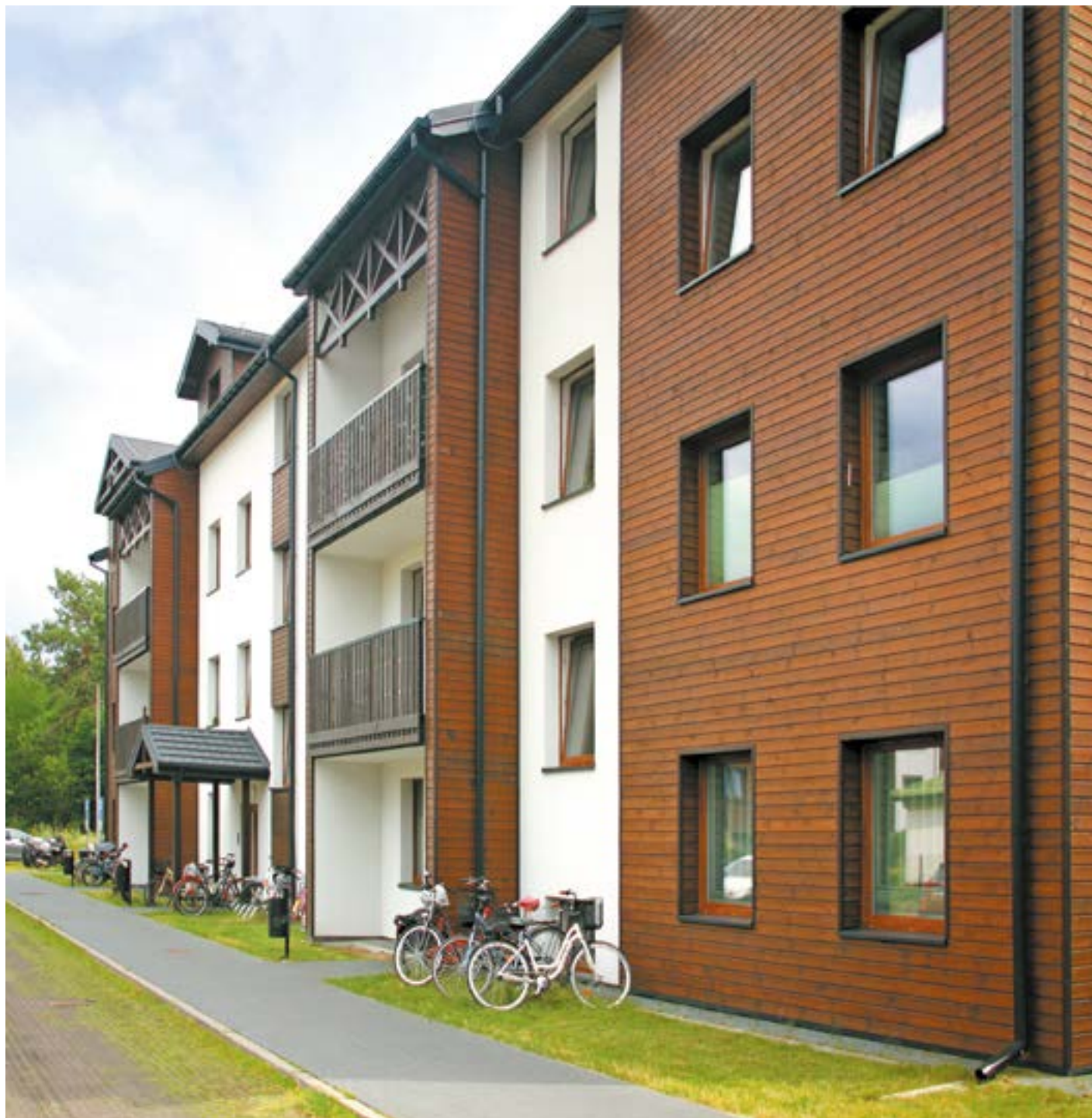
TBS przy ul. Rejtana – tak właśnie będą wyglądały nowe budynki z mieszkaniami, na które rozpoczął się nabór wniosków. Fot. Wojciech Siergiejczuk
