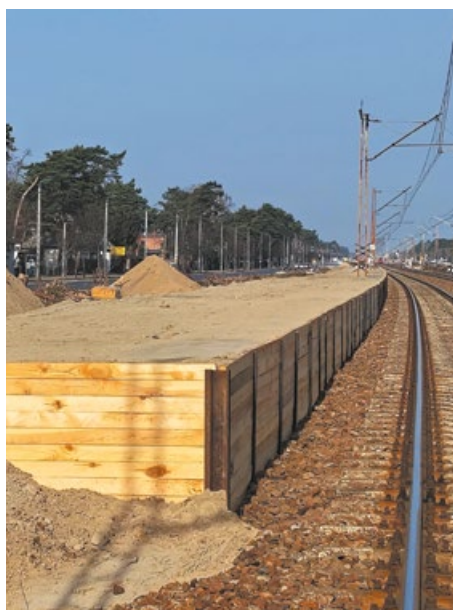
Trwa budowa tymczasowego peronu przy przejeździe kolejowym w Józefowie
