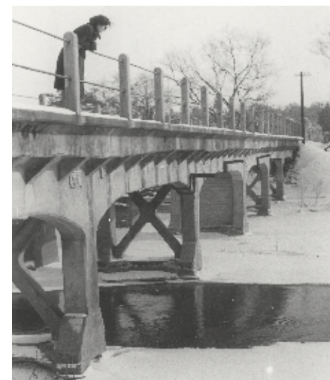
Most kolejki wąskotorowej wybudowany w latach 1912–1914.
