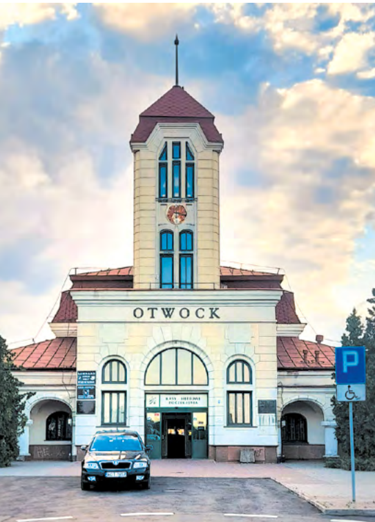
Budynek dworca kolejowego
