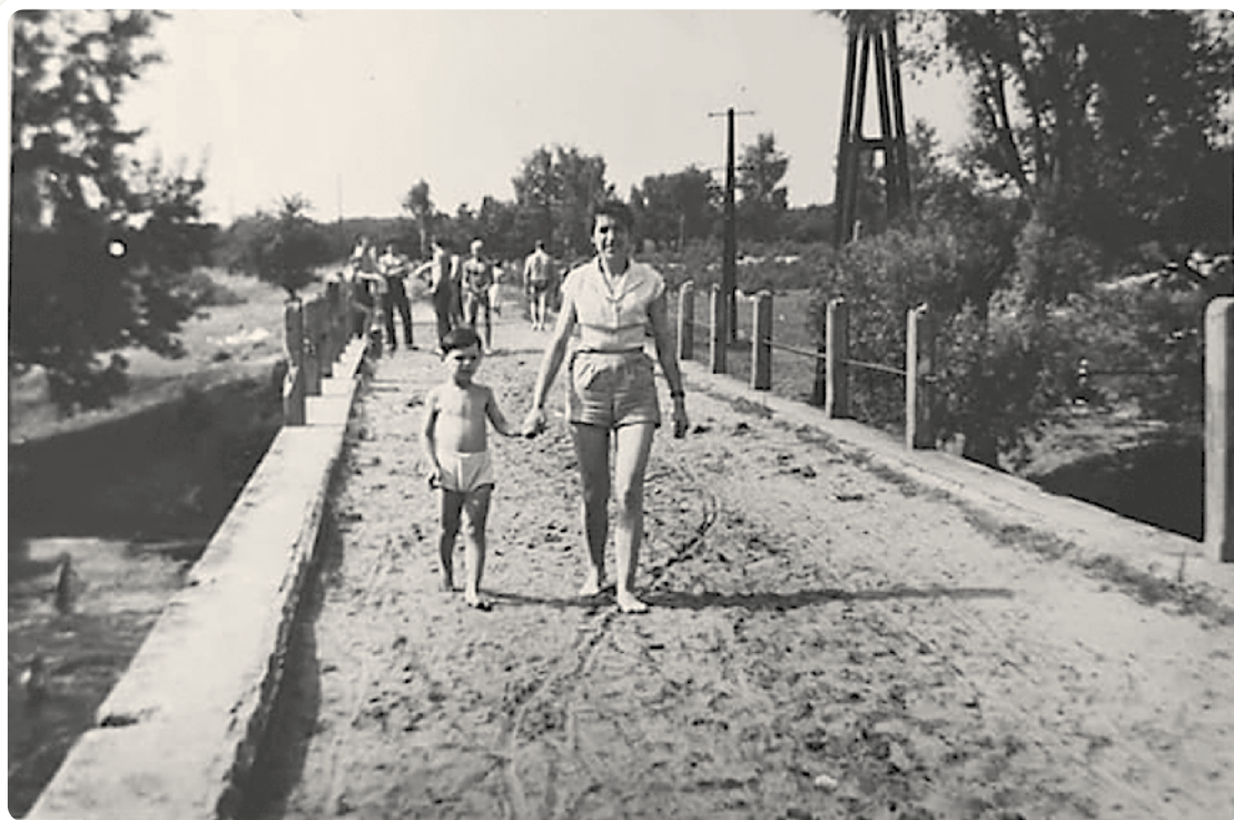
Lata 60. Irena Kowalewska z synem Arkadiuszem, most betonowy (kolejki wąskotorowej), widok w kierunku Józefowa. Z kolekcji Arkadiusza Kowalewskiego.
