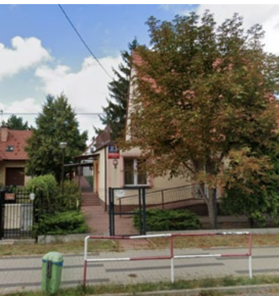
Przedszkole mieści się obecnie w dawnym domu jednorodzinny (fot. Google Street View)
