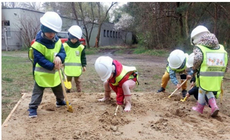
Uroczyste i wielokrotne wbijanie łopatek pod budowę nowej siedziby przedszkola odbyło się 3 kwietnia (fot. UM)
