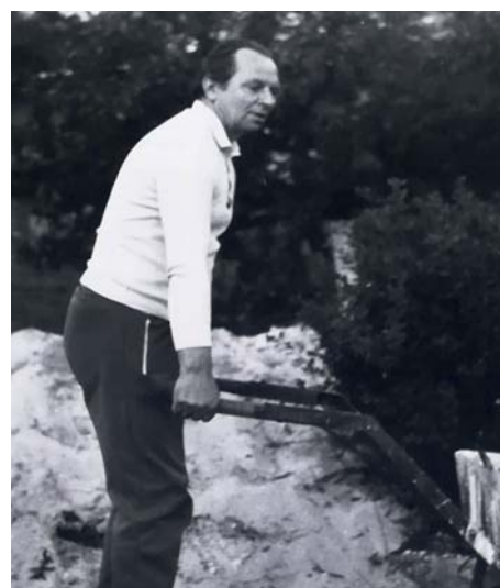
Jeden z założycieli klubu Kazimierz Chałtampowicz podczas prac przy budowie pierwszego budynku klubowego
