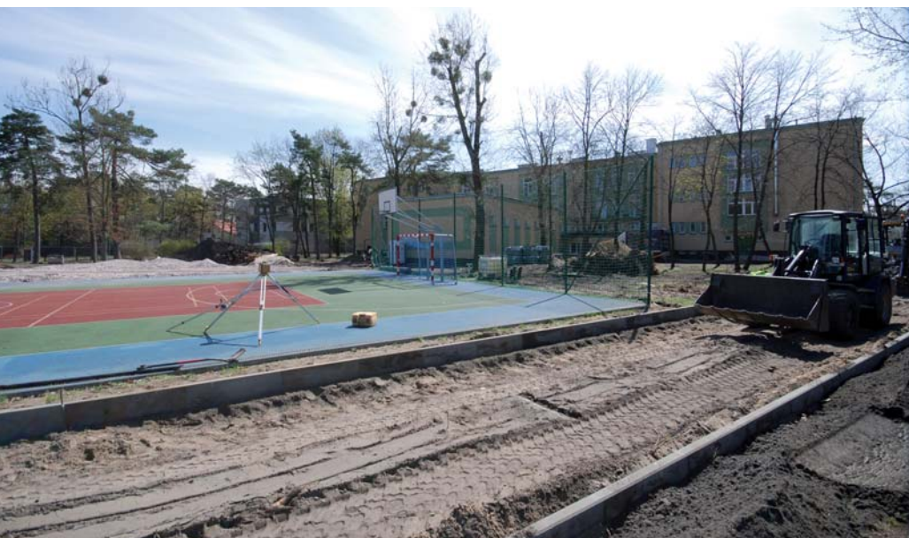
Budowa boisk przy SP2
