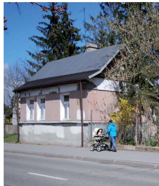
Budynek dawnej stacji kolejki wąskotorowej
